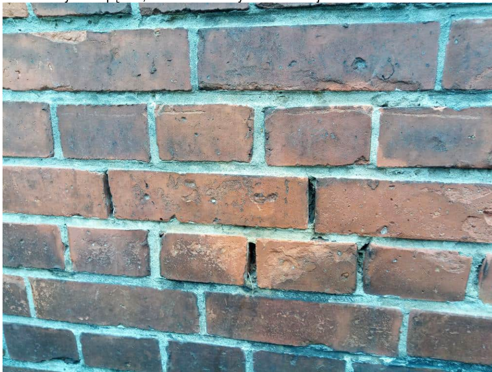
Fot. 8. Przykład spękań, zabrudzeń i ubytków elewacji
