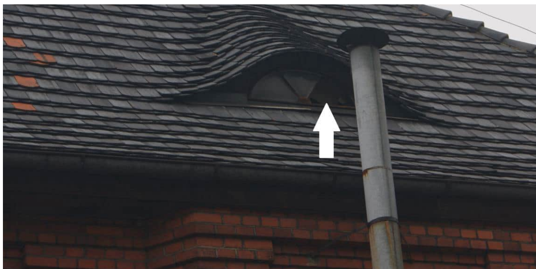
Fot. 1. Lukarna z brakującą szybą na dachu (zaznaczona strzałką) od strony południowej, umożliwiająca nietoperzom zasiedlenie strychu. Fot. J. Stępniewski.
