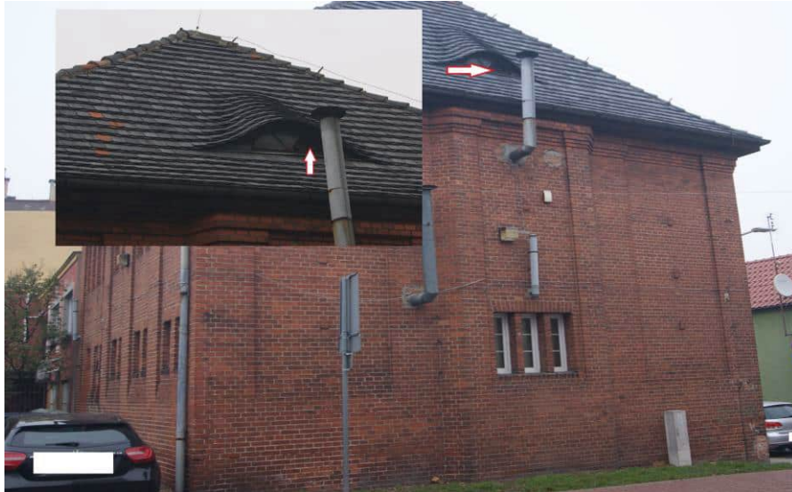
Fot. 1. Lukarna („wole oko”) z brakującą szybą na dachu (zaznaczona strzałkami) od strony południowej, umożliwiającą ptakom zasiedlenie strychu. Fot. J. Stępniewski.
