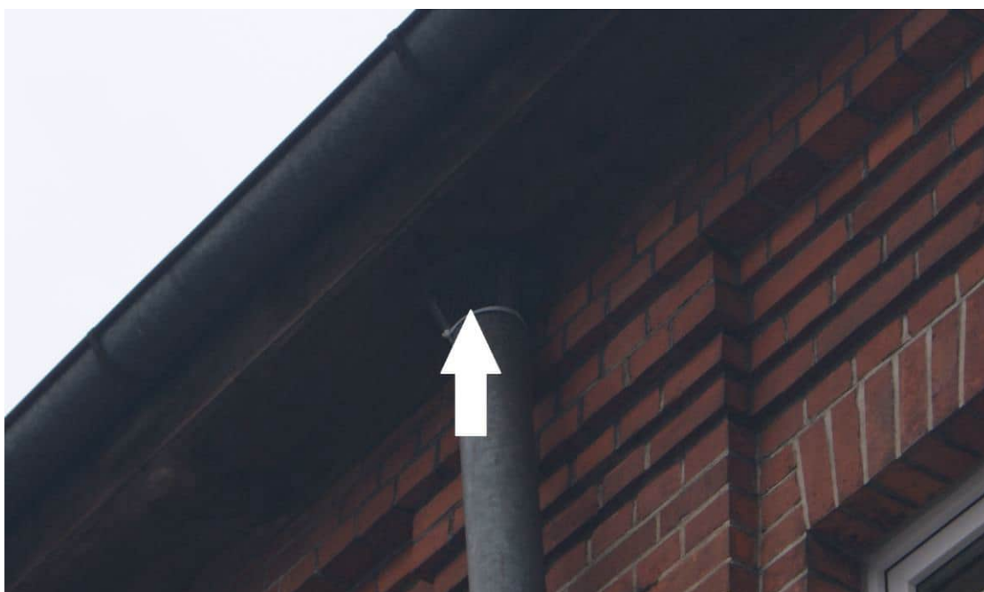
Fot. 3. Przykładowy wylot kominka wentylacyjnego na ścianie budynku zabezpieczony siatką o zbyt dużych oczkach stanowiące potencjalną kryjówkę nietoperzy. Fot. J. Stępniewski.
